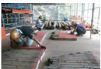
寸法・損傷調査
