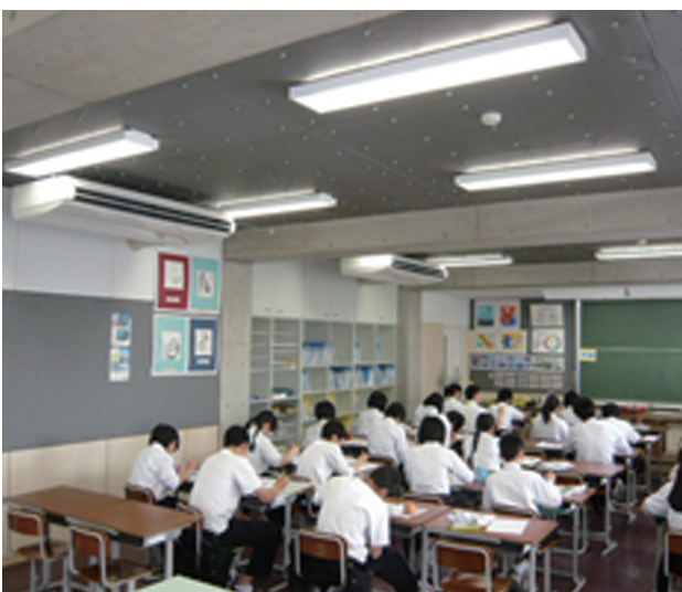
△空調設備整備（エアコン設置）
